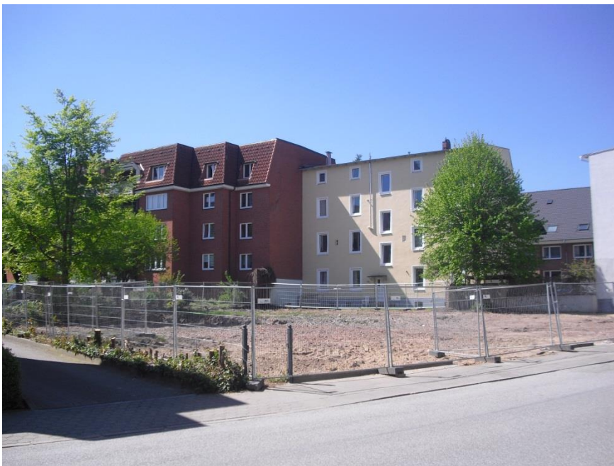
Blick auf das Grundstück nach Abbruch der Altbausubstanz
