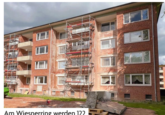
Am Wiesnerring werden 122 Balkone vorzeitig erneuert.
