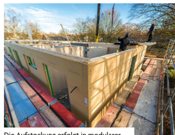
Die Aufstockung erfolgt in modularer Holzbaweise.
