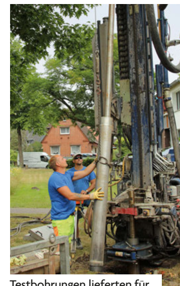
Testbohrungen lieferten für die Wohnanlage Billwiese gute Ergebnisse. Künftig wird hier die Erdwärme genutzt.
