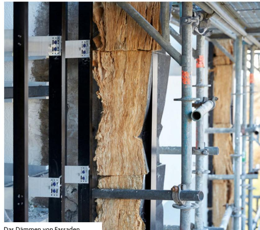
Das Dämmen von Fassaden vermeidet große Wärmeverluste.
