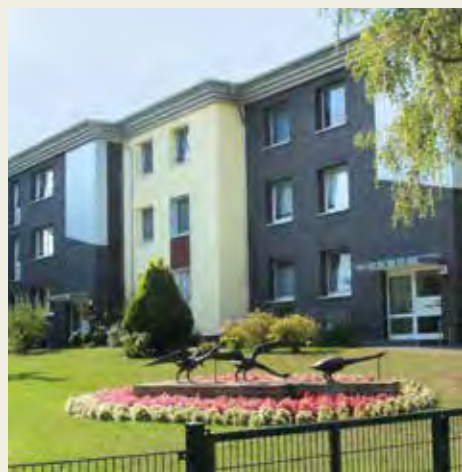
Die Häuser 103-107 wurden modernisiert, nachdem die Wohnanlage 2001 um einen Neubau ergänzt wurde.
