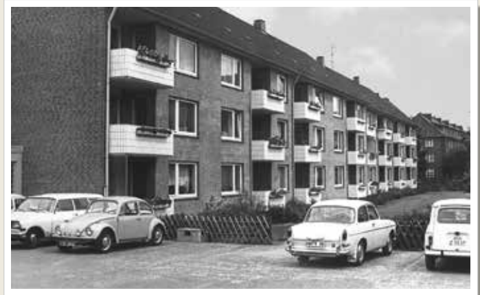
Blick auf die Rückseite der Sanmannreihe 59–65. Die Parkpalette wurde abgebrochen. An ihrer Stelle steht seit 2015 das Haus 67.
