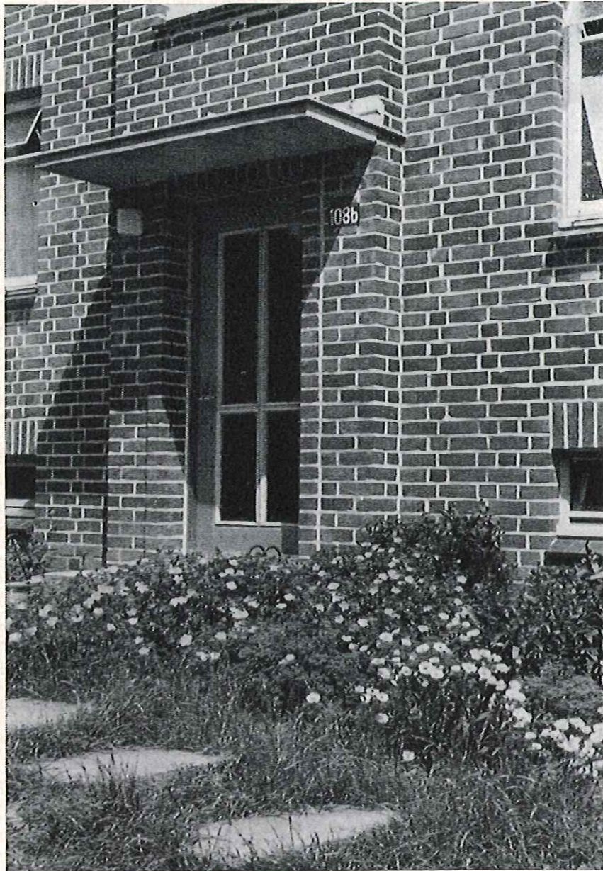
Eingang zu einem Mehrfamilien- wohnhaus (Wentorfer Straße in Hamburg- Bergedorf)
