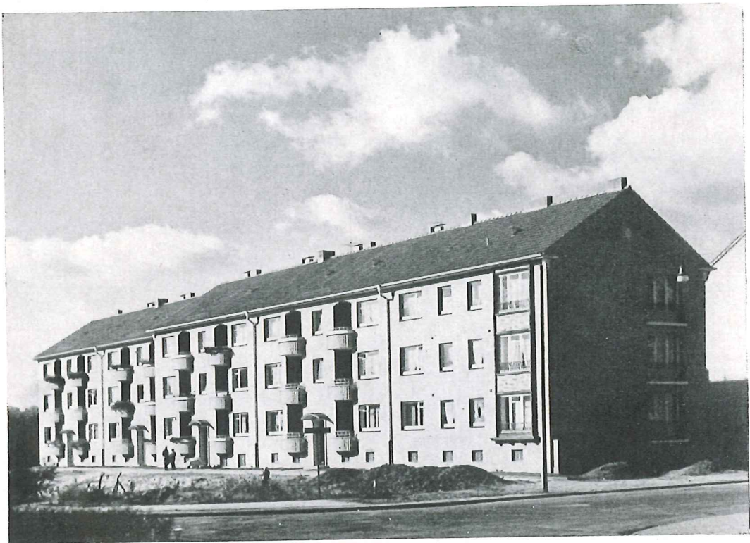
Neubau Johann-Meyer-Straße — I. Bauabschnitt — Ansicht Block zur Bahnhofsseite Lohbrügge
