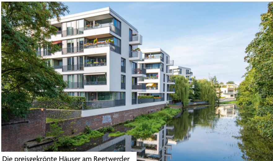
Die preisgekrönte Häuser am Reetwerder wurde 2008 auf einer Teilfläche des Bille-Bads errichtet.
