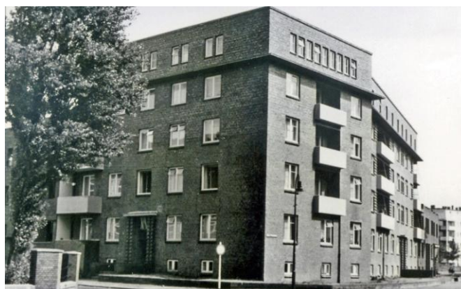
Wiederaufbau des Trümmergrundstücks: Am Pachthof und Am Hirtenkaten
