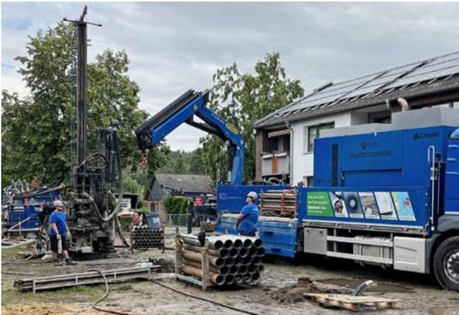
Im **Quartier Billwiese** wurde 2024 ein fertiggestelltes **Geothermiefeld** ans Netz angeschlossen. 42 Erdsonden liefern dort in Kombination mit Solar-Luft-Kollektoren Heizwärme für das zuvor energetisch ertüchtigte Quartier. Insgesamt 2,2 Mio. Euro wurden allein bei dieser Modernisierung in Klimaschutz und Versorgungssicherheit investiert.
