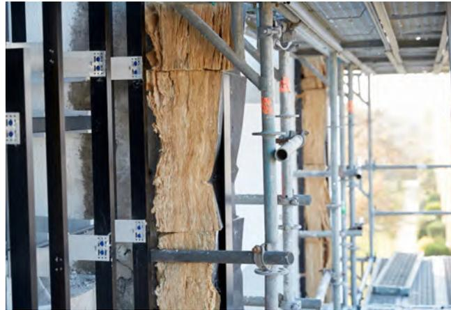
Das **Quartier Wiesnerring** wird fit für die Zukunft. 2024 wurde an der energetischen **Sanierung der Gebäudehüllen** gearbeitet und dabei die Fassaden gedämmt. Zugleich begannen bereits die Planungen für ein neues Nahwärmenetz sowie für die neue Wärmeversorgungsanlage. Es wurden rund 3,0 Mio. Euro investiert. In den nächsten Jahren wird es weitere Bauabschnitte geben.
