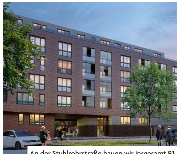
An der Stuhlröhrestraße bauen wir insgesamt 93 Wohnungen in unterschiedlichen Wohnformen.
