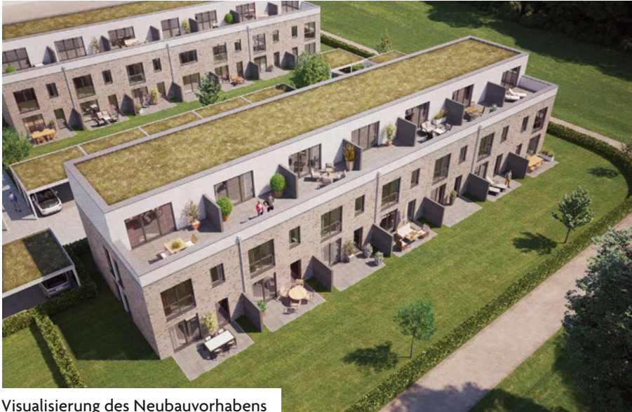
Visualisierung des Neubauvorhabens
