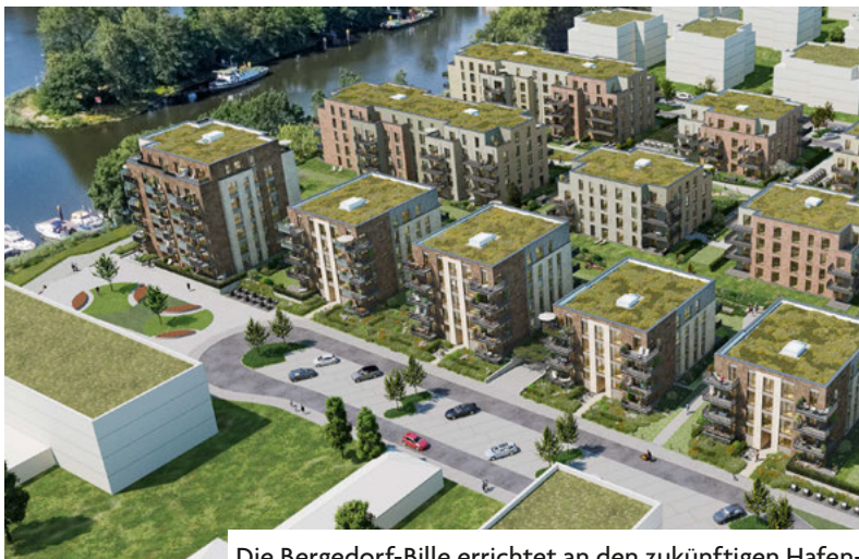
Die Bergedorf-Bille errichtet an den zukünftigen Hafenterrassen zwei vier- und ein fünfstöckiges Gebäude
