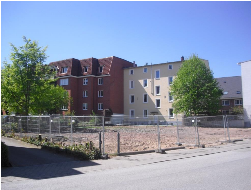
Blick auf das Grundstück nach Abbruch der Altbausubstanz
